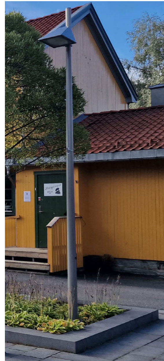
Armatur brukt på Spikkestad torg med anbefalt farge RAL9007 fra formingsveilederen
